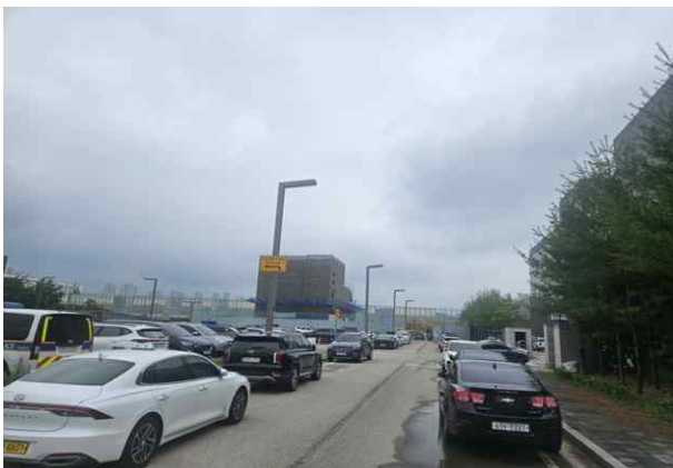
위 치 송수-4(2), 5(3) (Sta.9+3.0) 손상내용 포장 및 지반 상태양호
