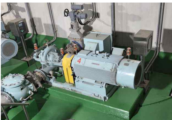
손상내용 펌프실 지하 설비 전경 손상원인 -
