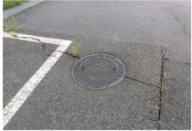
환기구 등의 덮개(유량계실 입출구) 현황
