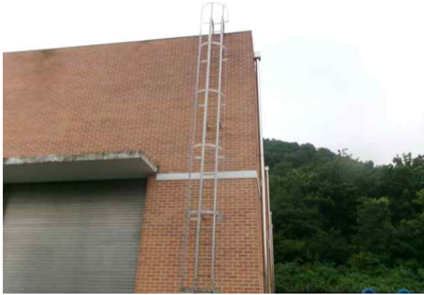
옥상층 진입사다리 상태양호
