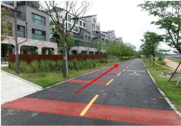
위 치 송수-4, 5 (Sta.282+0.0, Sta.3+10.0) 손상내용 포장 및 지반 상태양호
