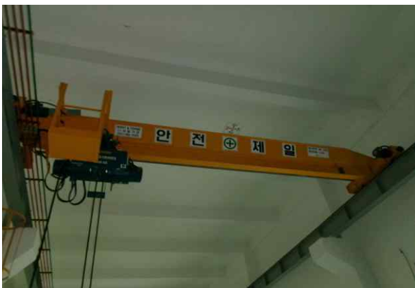
손상내용 펌프실 호이스트 상태양호 손상원인 -
