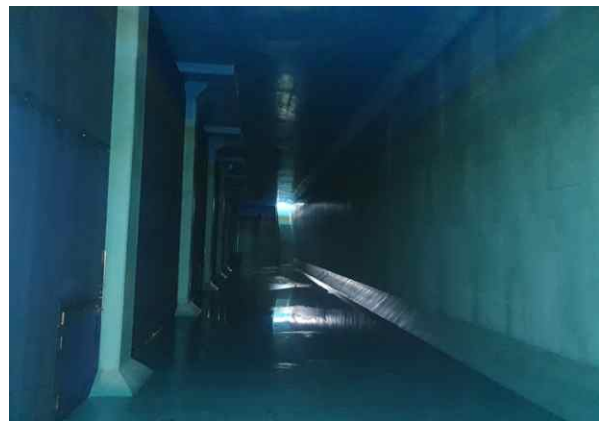
배수지 4지 내부 전경
