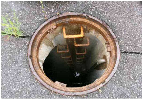
유량계실 출입구 전경
