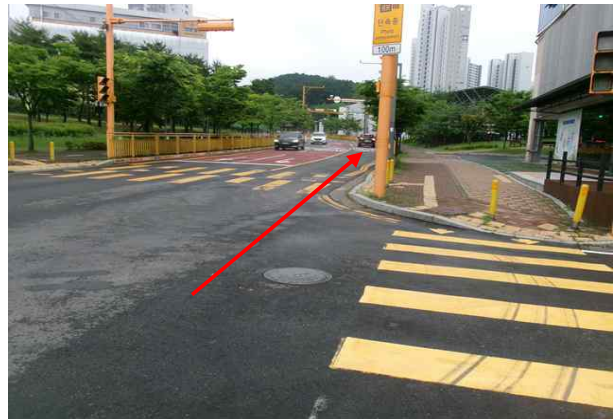
위 치 송수-3 (Sta.10+14.3) 손상내용 포장 및 지반 상태양호
