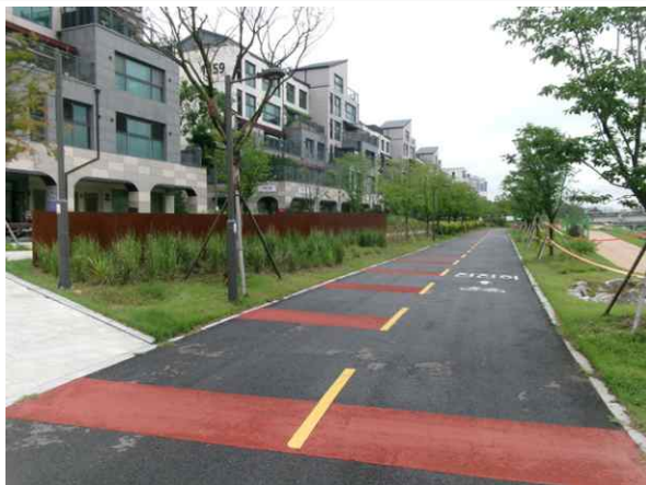
송수-4,5 시점부 전경
