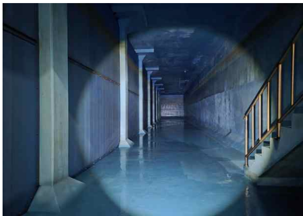
배수지 3지 내부 전경
