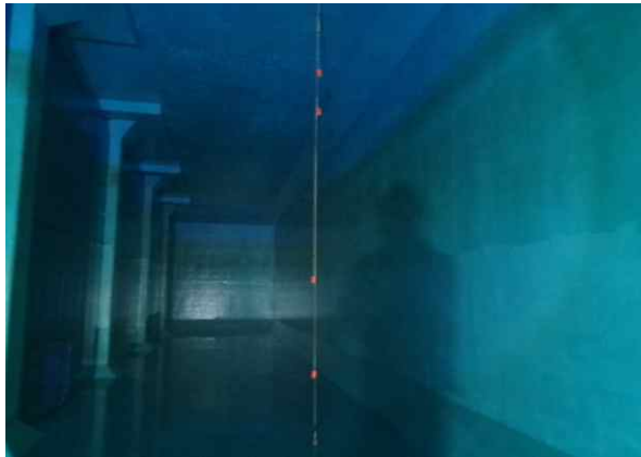
배수지 1지 내부 전경
