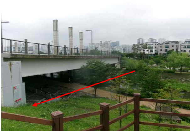
위 치 송수-1, 2 (Sta.66+1.0) 손상내용 포장 및 지반 상태양호
