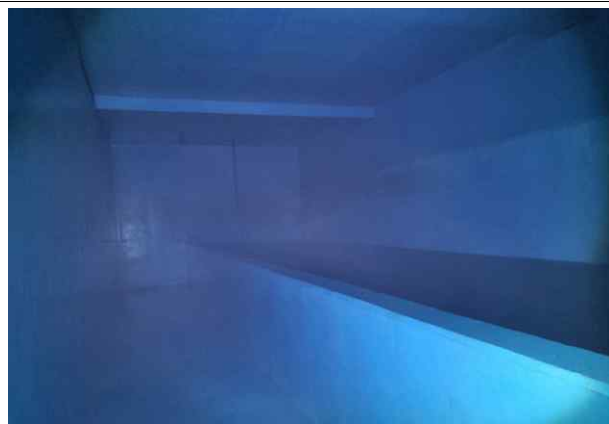
저류조 및 흡수조 1지 내부 전경
