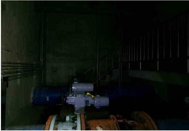
유입배관실 내부 전경
