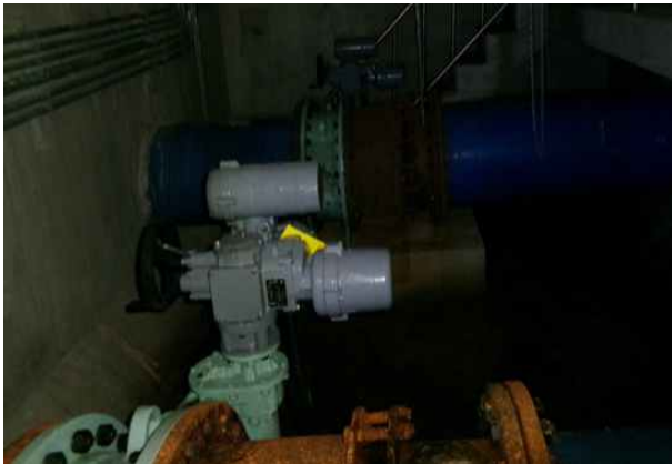
손상내용 배관실 유입밸브 상태양호 손상원인 -
