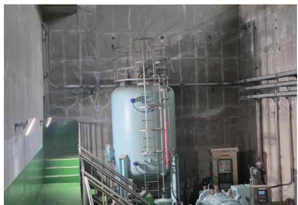
손상내용 펌프실 지하 설비 전경 손상원인 -
