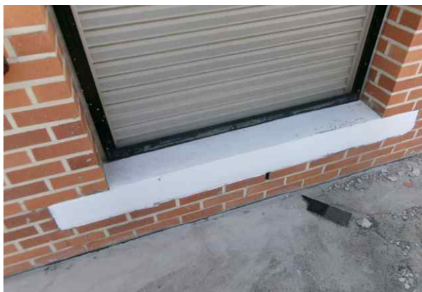
손상내용 1~2호지 검수실 외부 균열(0.3mm미만) 손상원인 건조수축, 온도변화
