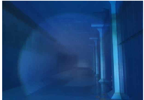
배수지 2지 내부 전경
