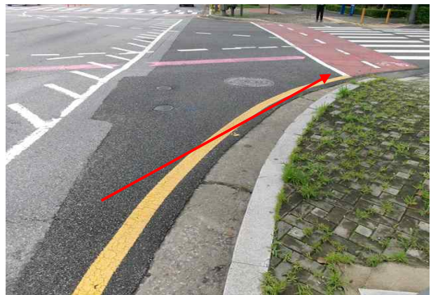
위 치 송수-6 (Sta.0+0.0) 손상내용 포장 및 지반 상태양호
