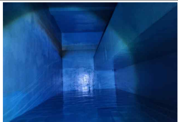
저류조 및 흡수조 2지 내부 전경
