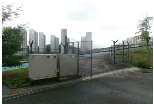
진입로 포장 현황
