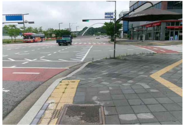
위 치 송수-4, 5 (Sta.315+6.0, Sta.36+16.0) 손상내용 포장 및 지반 상태양호
