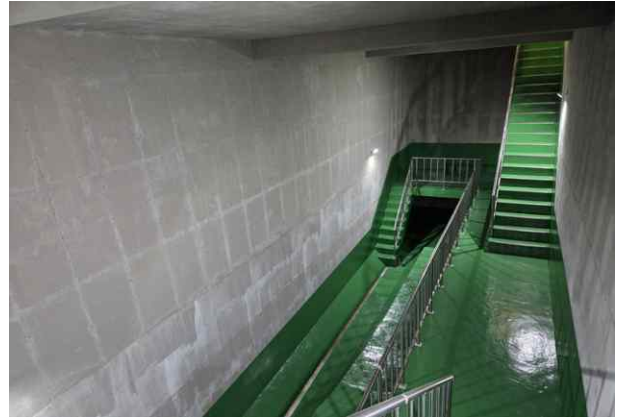
유출배관실 내부 전경
