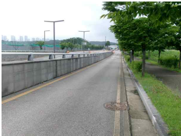
송수-1,2 시점부 전경
