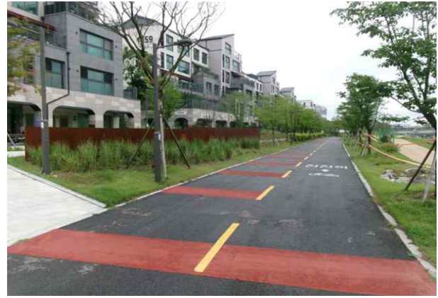
송수-4,5 시점부 전경
